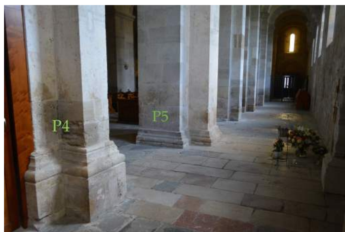
Abb. 13: Unterschiedliche Sockelhöhe
