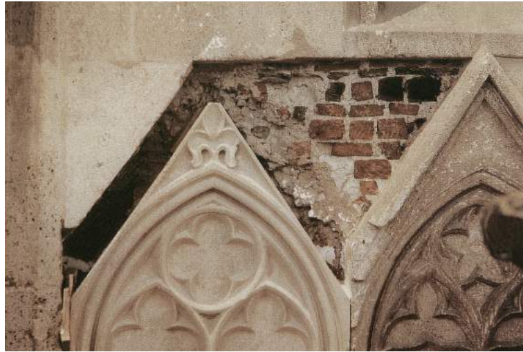
Abb. 19: Freigelegte Zwischenräume der Maßwerkgiebel
