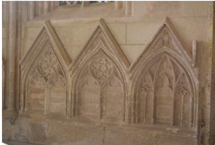
Abb. 18: Maßwerkplatten im Brunnenhaus (Wandabschnitt 1)
